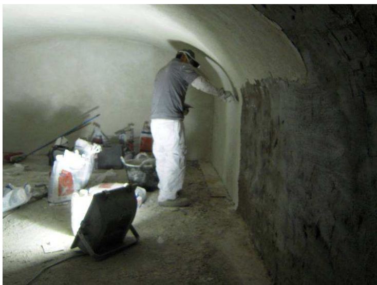
Foto 29 Capa revoco permeable
