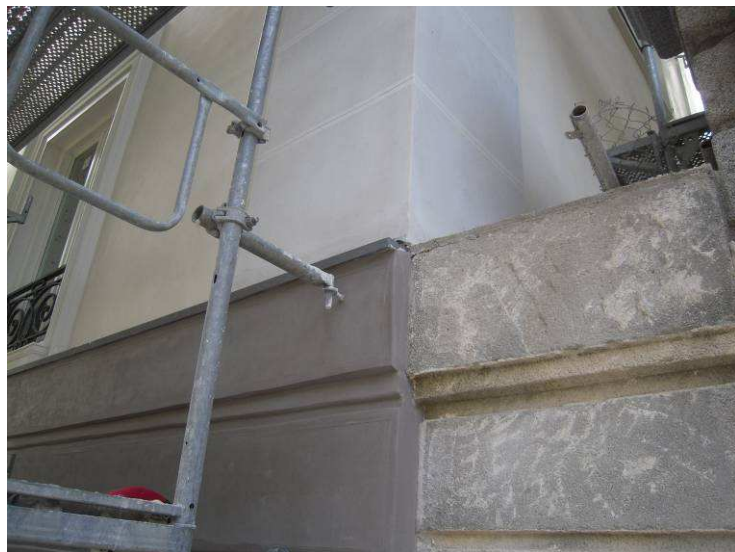
Foto 14 Aplicación con martillina
