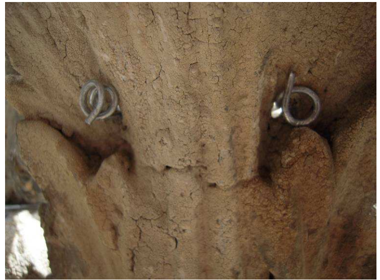
Detalle del nuevo anclaje de acero inoxidable
