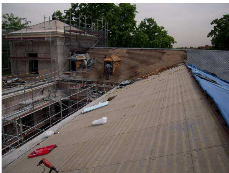
Foto 3 Desmontaje cubierta pizarra
