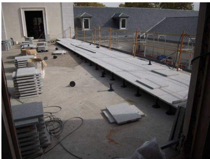
Foto 11 Montaje cubierta plana
