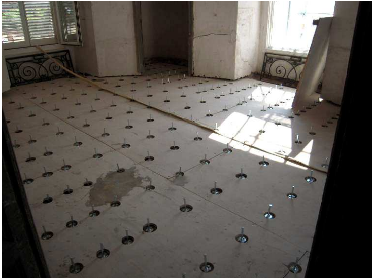
Foto 21 Conectores refuerzo Torreones
