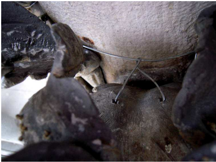
Detalle del nuevo anclaje de acero inoxidable
