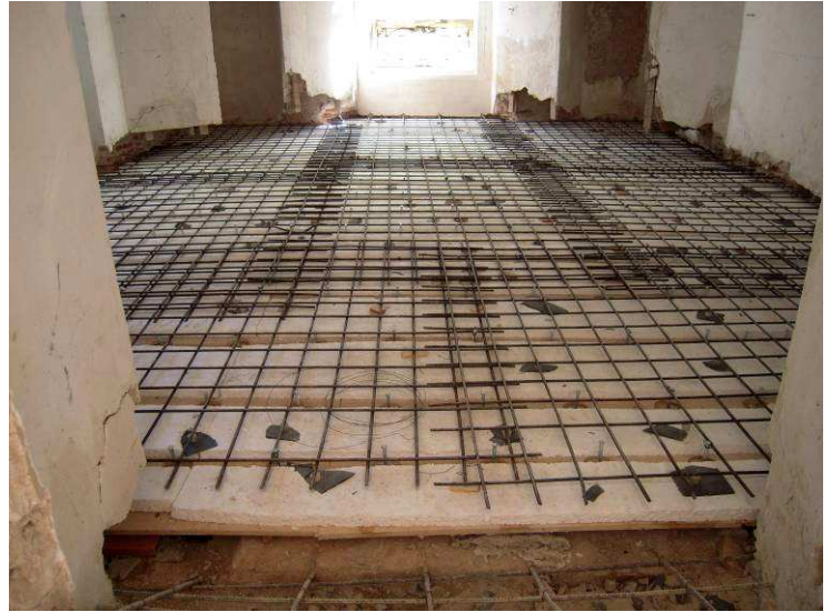
Foto 22 Armado forjado Torreones
