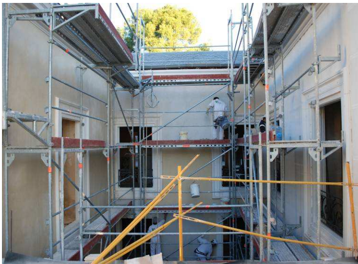
Foto 13 Aplicación revoco liso cal
