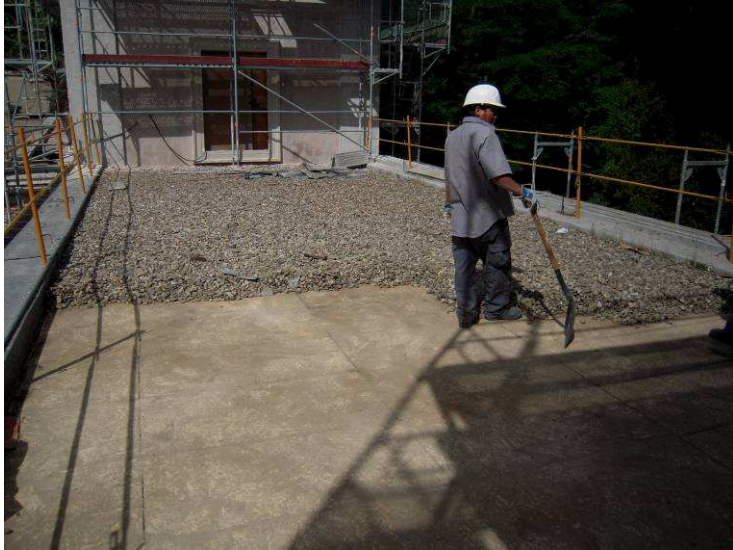
Foto 5 Desmontaje cubiertas planas
