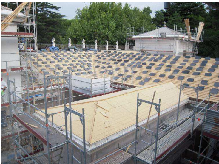
Foto 9 Colocación fenólico + Cubierta pizarra
