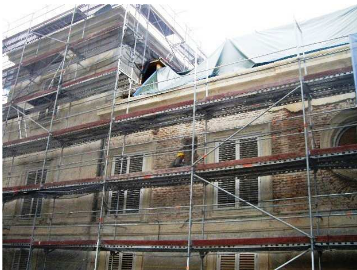
Foto 1 Demolición de paramentos
