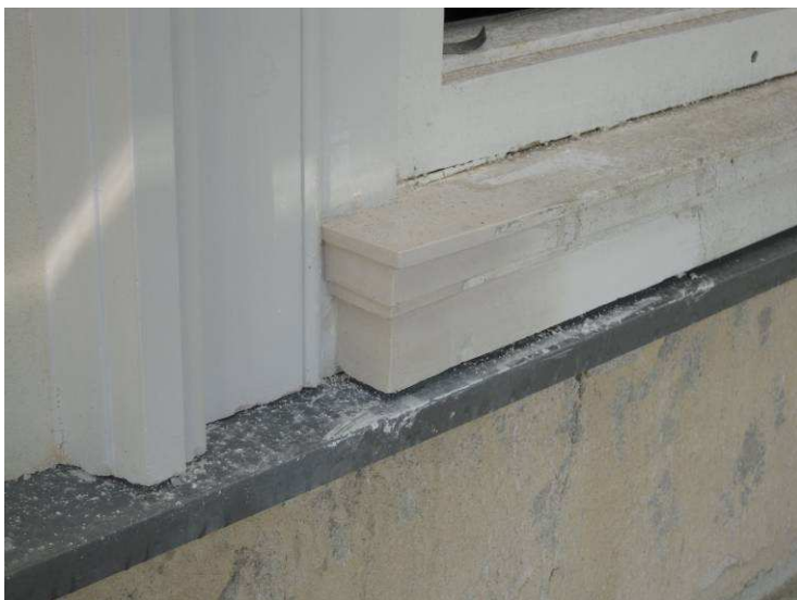
Foto 15 Colocación molduras nuevas
